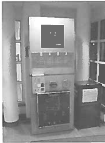
مرکز کنترل MXL ساخت زیمنس به همراه سیستم هشدار دیداری
